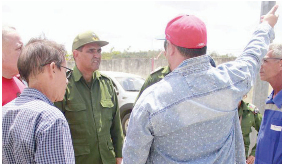
El presidente del Consejo de Defensa Provincial, Liván Izquierdo Alonso, al centro, recibe detalles acerca del trabajo de restauración del servicio en la subestación.
