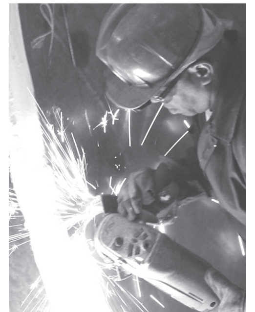
Construcción de cisternas.
