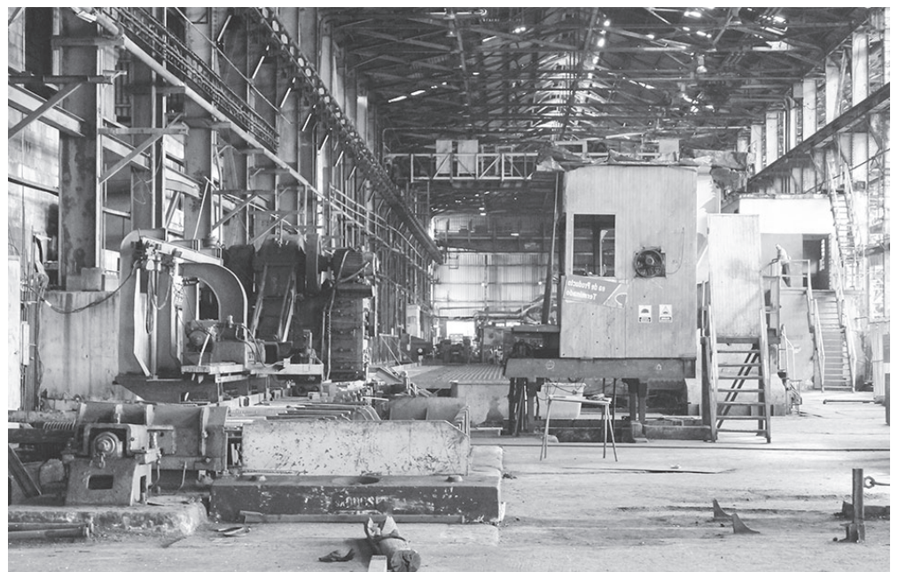
Talleres en proceso de reparación de la Empresa Antillana de Acero.
