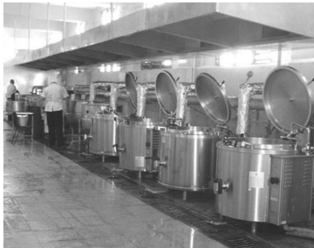
Cocina restaurada del Hospital Psiquiátrico de La Habana.
